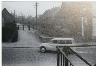
Na prawo od wału przebiegał kanał służący jako rów odwadniający.
