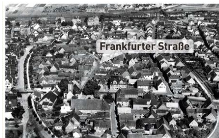
Na zdjęciu lotniczym dobrze widać Frankfurter Straße oraz przebieg wału.
