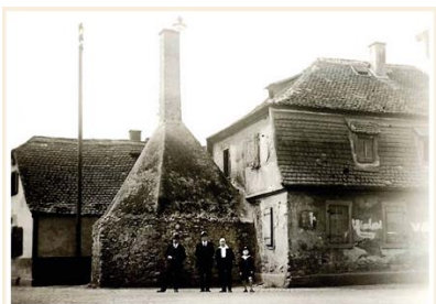
Piec na krótko przed wyburzeniem.
